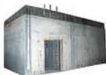
Trezorski prostor po zalitju z betonsko mešanico in razopaženjem
