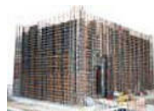
Varnostna in statična armatura trezorskega prostora, pripravljena za opaženje in nato zalitje z betonsko mešanico
