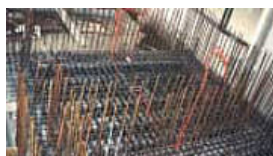
Postavitve varnostne in statične armature se opravljata sočasno
